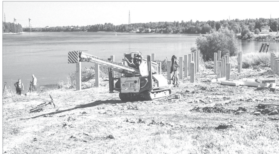
Благоустраивается набережная Свири – от причала до братского захоронения
